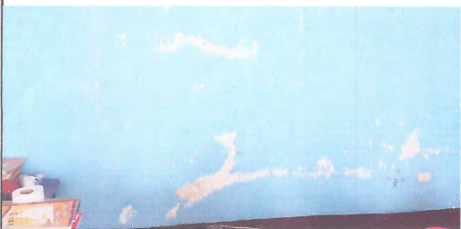
Foto 3: Filtración de agua en una de las aulas del centro estudiantil.
